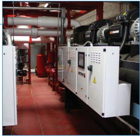
Armstrong 集成式冷冻机房提供最佳空间、能耗和环境效率的解决方案。制冷量范围为60 Hz时 80到1,000冷吨，50 Hz时 300到3,600 kW。
