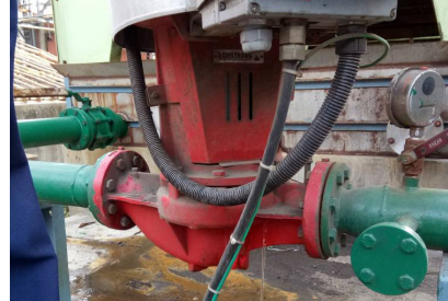
ABB. 2: WASSERAUSTRITT AUS GEROSTETEM GEHÄUSE, OHNE KATAPHORESE-LACKIERUNG
